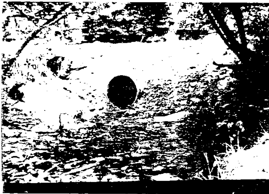
Fig. 30 Alcantarilla simple de tubo de concreto.
