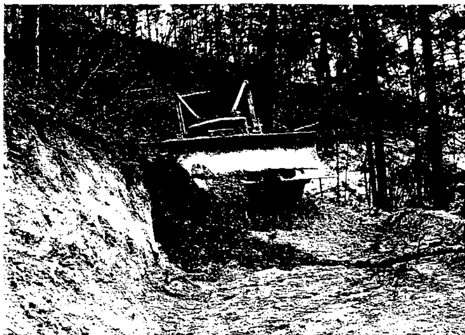
Fig. 16 Ampliando plantilla y elaborando talud.
