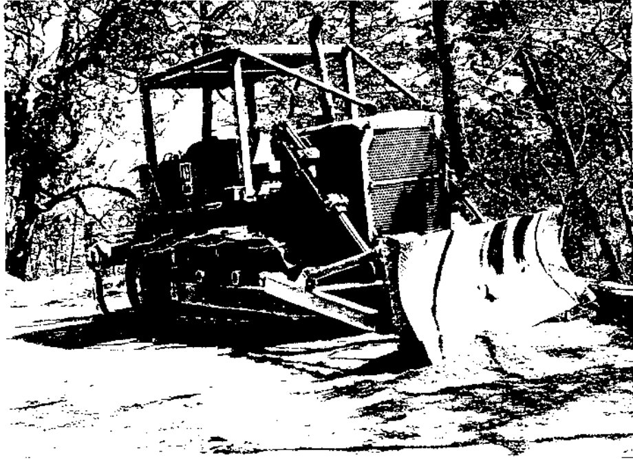
Fig. 17 Tractor de orugas utilizado en la construcción de caminos forestales.
