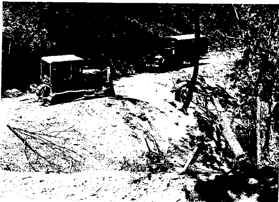
Fig. 29 Construcción de un desagüe con el tractor de orugas.
