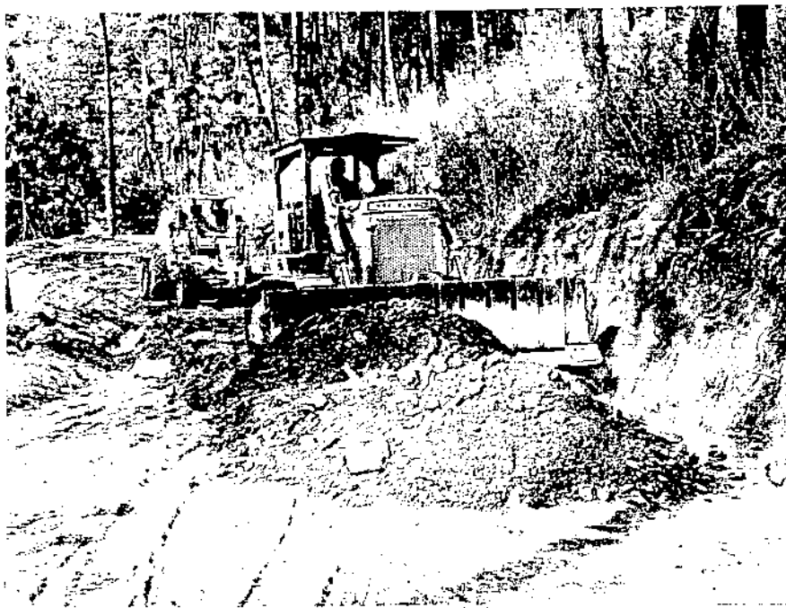
Fig. 29 Tendido de material.
