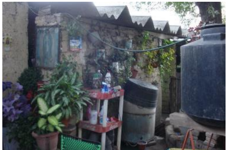
Imagen 33. Contenedor de 1,000 litros conectado a la manguera de distribución.
