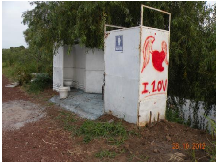
Letrina al margen del río Duero
