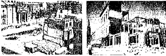
Demolición de fincas frente a Catedral para construir la Cruz de Plazas
