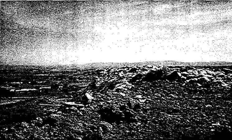
Imagen N 8.-Montaña de residuos mezclados con tierra, no compactados del Relleno Sanitario de Planta Laureles, de los cuales se puede observar residuos de todo tipo aun dentro de las bolsas como fueron recolectados, sin poder darles una separación adecuada.
