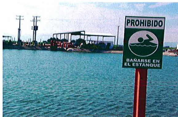
Figura 8. Presa para abastecimiento de agua (Luna y Huitrón, 2007).
