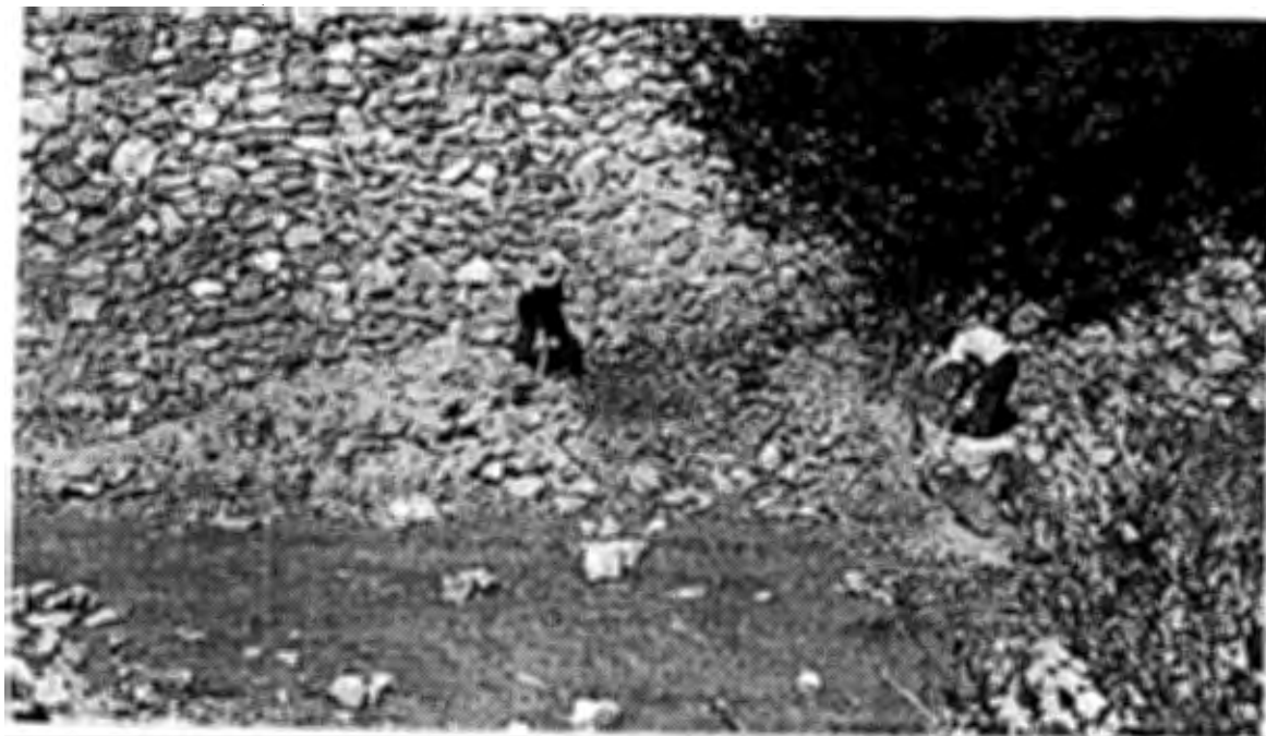
FOTO 2.- REHABILITACION DE OLLA DE AGUA EN EL MPIO . DE CADEREYTA, QRO.
