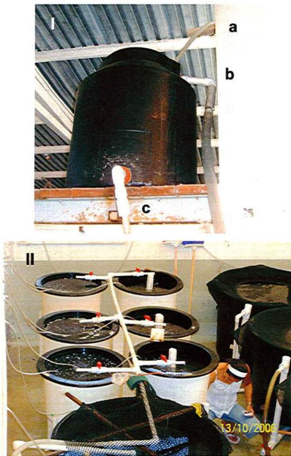
Figura 8. ( I ) Tanque de suministro de agua para las incubadoras: (a) Manguera de suministro principal, (b) Manguera de rebozo, (c) Manguera de suministro para las incubadoras. ( II ) Disposición de Incubadoras, sistema de distribución de agua y aire.
