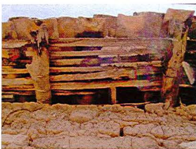
Tejado construido con cintas de madera de Pachycereus pecten-aboriginum
