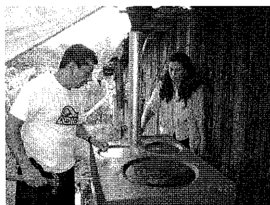
Construcción de estufa Lörenä
