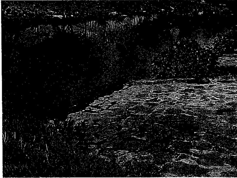
**Foto 41.** Misma sección del canal que la fotografía anterior, en donde se observa el nivel de agua pluvial estancada y la aparición de maleza en las márgenes del mismo.
