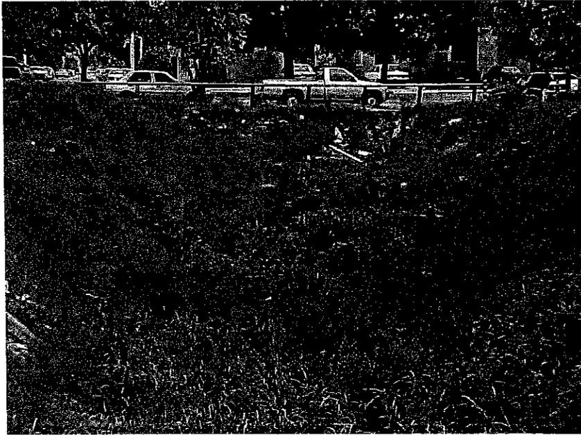
Foto 31. Inicio de Canal Interceptor en Av. Mariano Otero en donde se observa el crecimiento de maleza en el cauce disminuyendo su capacidad de captación de agua pluvial.
