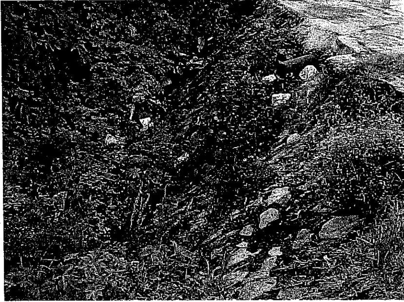
**Foto 59.** Aquí termina el canal. El tubo que se observa es de desagüe de agua pluvial proveniente de la avenida Lázaro Cárdenas. Se observa que el canal se encuentra tapado, existe una acumulación de basura y un gran crecimiento de malezas por el temporal de lluvias.
