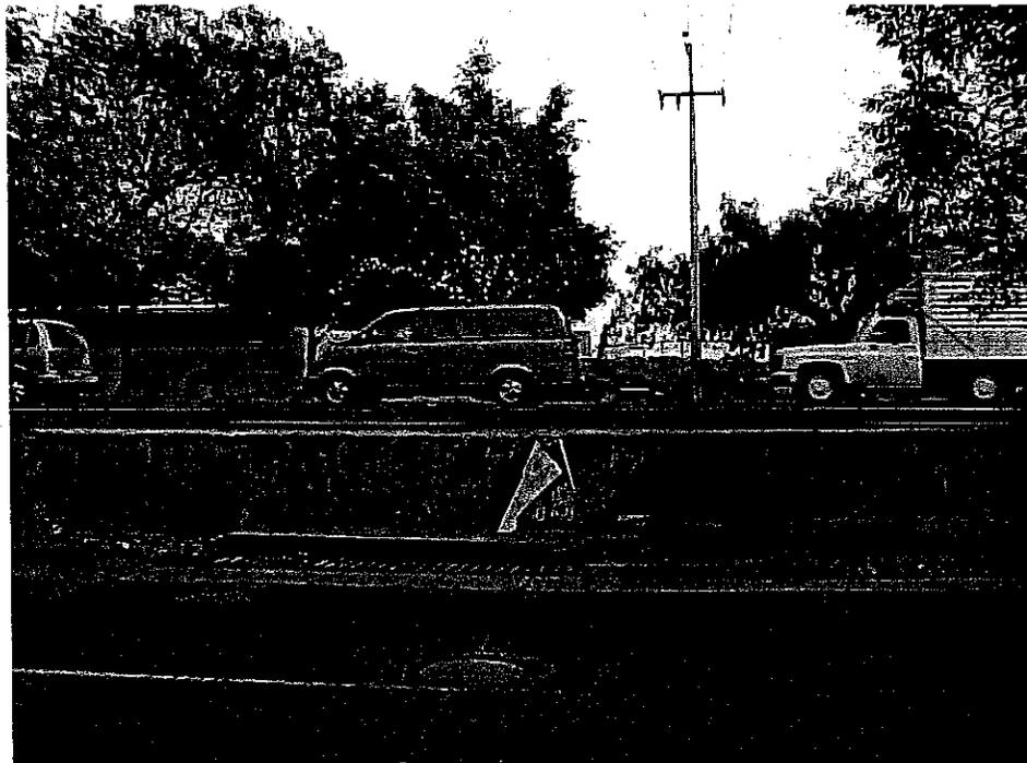
Foto. 2. Boca de Tormenta frente a la tienda Viu. Lateral de la Av. López Mateos. Carril central elevado que funciona como dique a los escurrimientos pluviales debido a que la boca de tormenta se tapa con la basura que es arrastrada por la lluvia.
