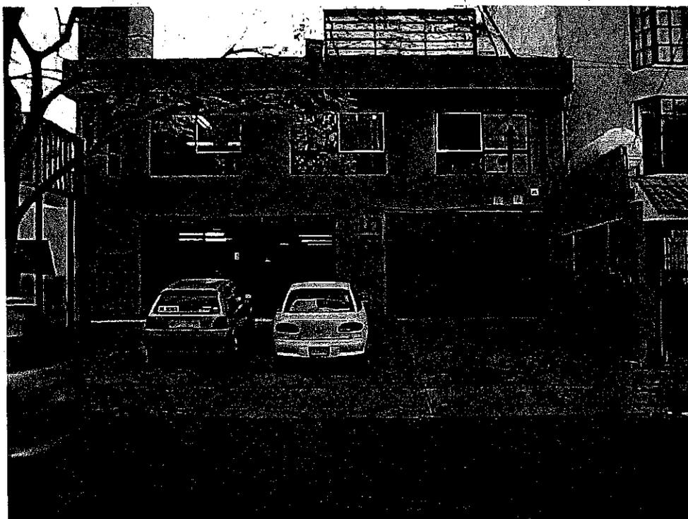
Foto 9. Calle Popocatépetl. Construcción elevada para evitar el riesgo de inundación dentro del inmueble.
