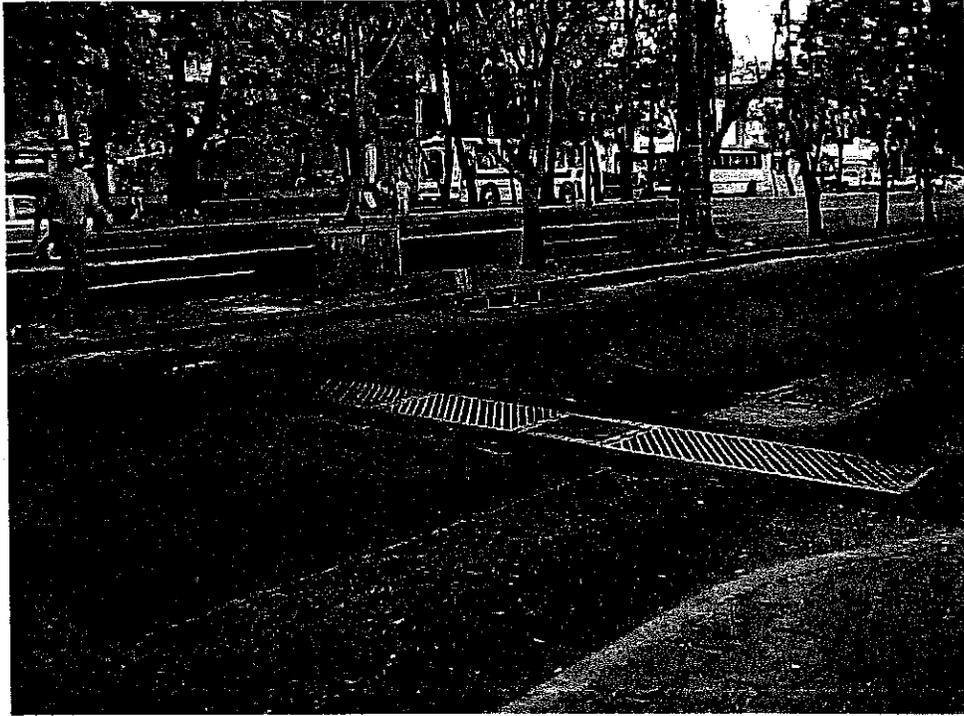
Foto 25 Lateral Poniente López Mateos, boca de tormenta (Sanborn's), construida para la reducción del riesgo de inundación pluvial, por parte de las autoridades correspondientes del Gobierno de Jalisco (SIAPA).
