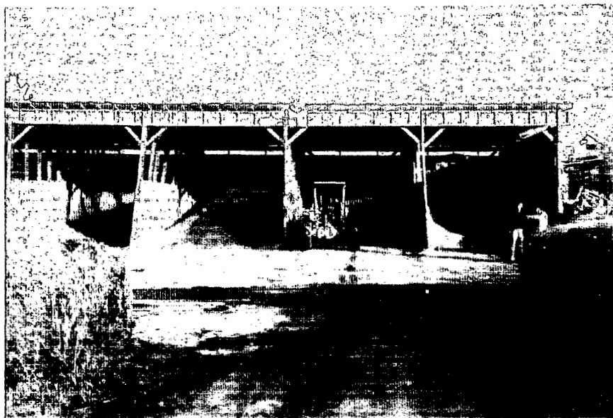
Figura 2. Almacén de los aditivos utilizados en la elaboración de composta.
