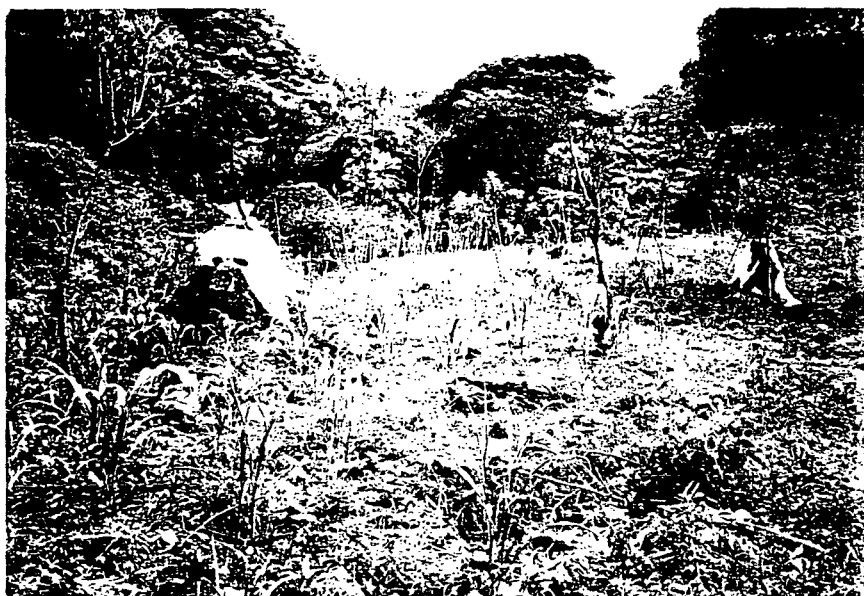
DESMONTE Y ESTABLECIMIENTO DE COAMILES
