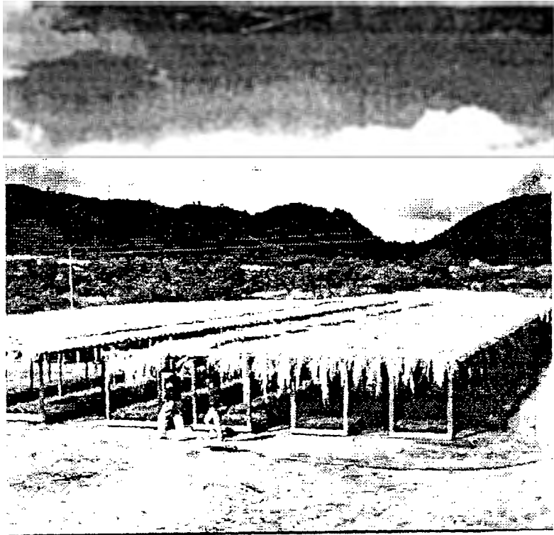
FOTO No. 6.- MEDIAS SOMBRAS EN PLATABANDAS CONCLUIDAS
