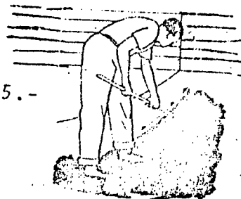
Nivelar el suelo
